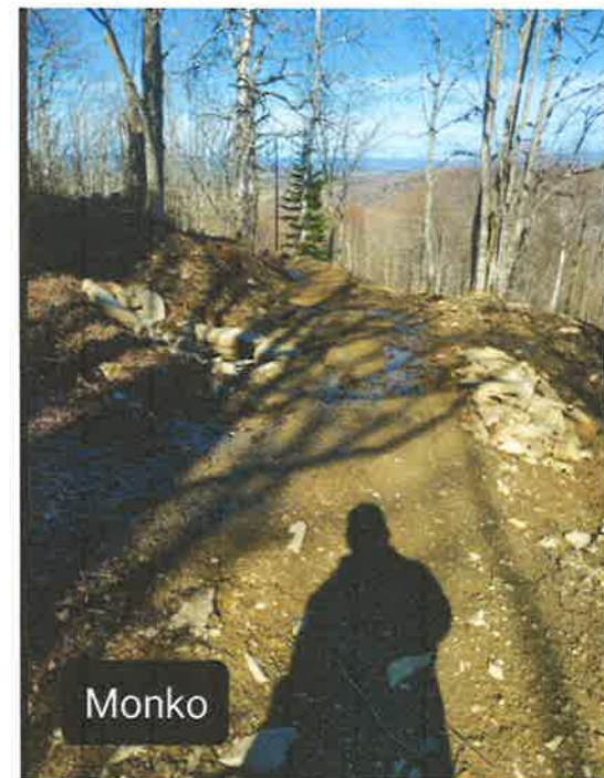
SECTION 2 RÉPARATION SURFACE AMÉLIOATION DRAINAGE
