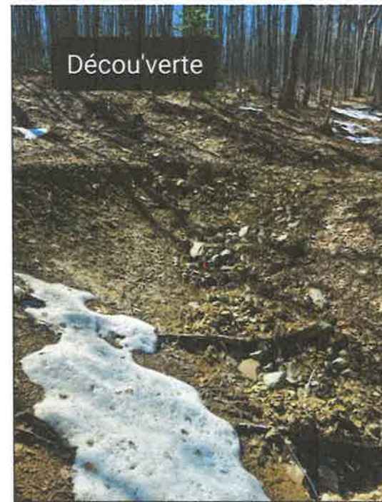
RÉPARATION DURFACE CREUSÉ EN HUT DU BERM POUR SORTI D'EAU
